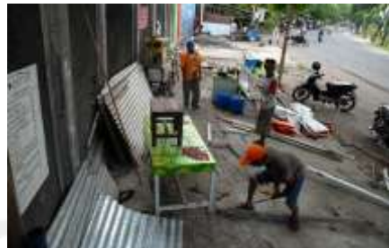
Gambar III.6 Pembongkaran kios PKL Tahun 2009 dan kondisi kios pasca relokasi Tahun 2010
