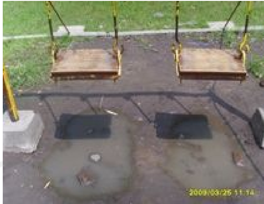
Gambar 2.16 Kondisi Tempat Bermain pada Musim Hujan
