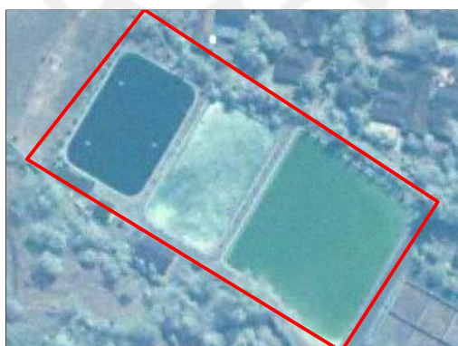
Gambar 27. Objek kolam IPAL
