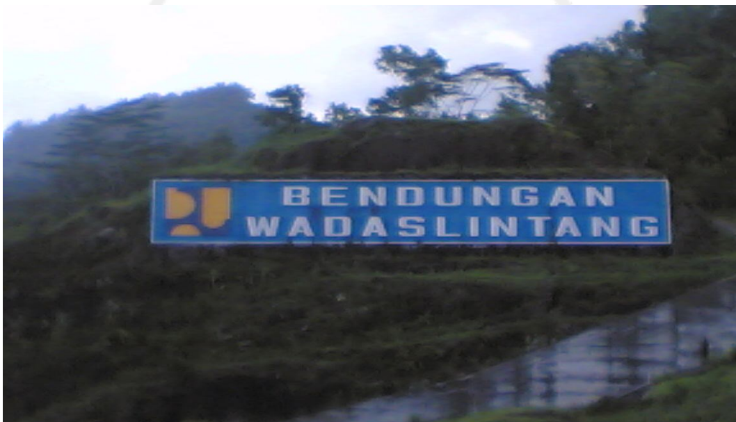
Gambar 4. Gambar Bendungan Waduk Wadaslintang
