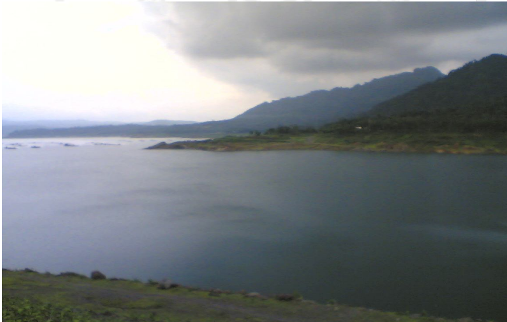
Gambar 3. Gambar Bendungan Waduk Wadaslintang
