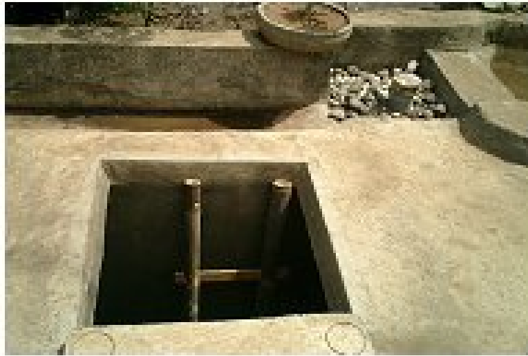
Gambar 2.5 Bak Penampungan Air Buangan di Bandara Internasional Adi Soemarmo Surakarta
