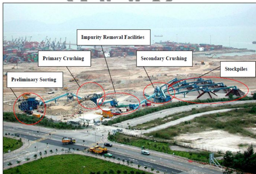
Gambar 2.4. Proses produksi agregat daur ulang di Tuen Mun Area 38 (Fong dan Yeung, 2003)
