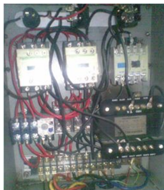
Gambar 4.1. Rangkaian kelistrikan pada mesin bubut
