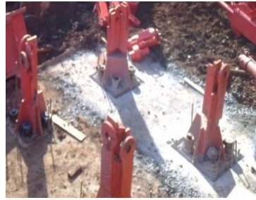
Gambar 6. Pemasangan mal angkur Sumber : PT. Tatamulia Nusantara Indah, 2010.
