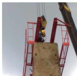
Gambar 9. Pemasangan balance atau beban penyeimbang
