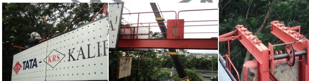
Gambar 19. Melepas balance atau beban penyeimbang (4)
