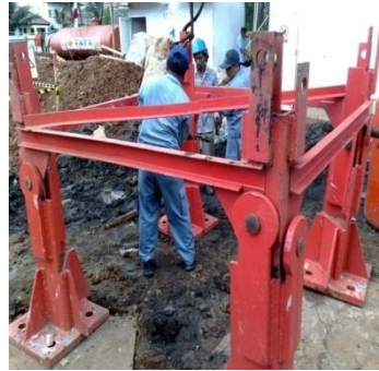
Gambar 7. Pemasangan basic tower crane Sumber : PT. Tatamulia Nusantara Indah, 2010.
