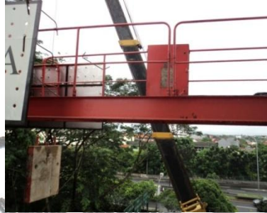
Gambar 21. Melepas balance atau beban penyeimbang (1) Sumber : PT. Tatamulia Nusantara Indah, 2011.
