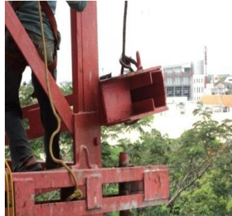
Gambar 16. Pembongkaran anchorage Sumber : PT. Tatamulia Nusantara Indah, 2011.
