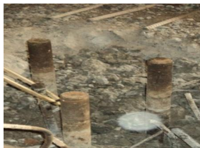
Gambar 27. Melepas angkur atau kaki tower crane Sumber : PT. Tatamulia Nusantara Indah, 2011.
