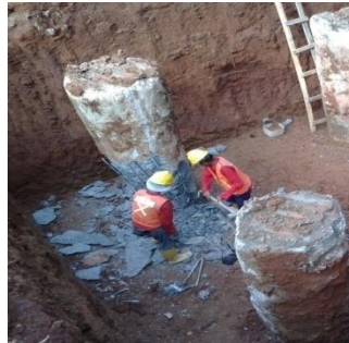
Gambar 3. Penggalan pondasi tower crane Sumber : PT. Tatamulia Nusantara Indah, 2010.
