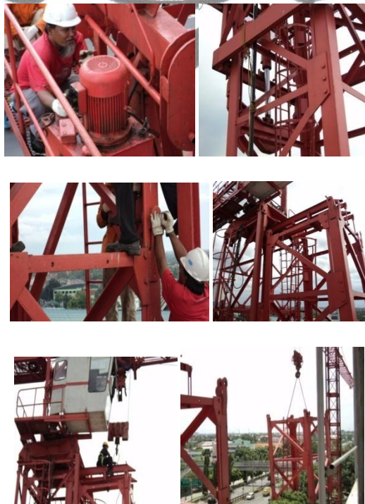
Gambar 15. Pembongkaran section dan pin Sumber : PT. Tatamulia Nusantara Indah, 2011.
