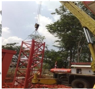
Gambar 8. Pemasangan section dan pin Sumber : PT. Tatamulia Nusantara Indah, 2010.
