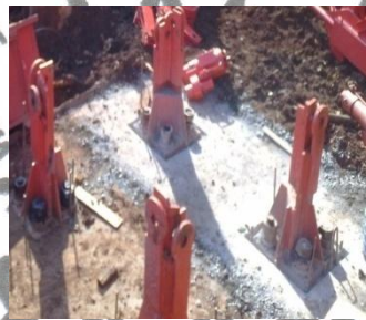
Gambar 5. Besi atas pondasi tower crane Sumber : PT. Tatamulia Nusantara Indah, 2010.
