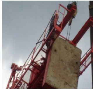
Gambar 10. Pemasangan balance atau beban penyeimbang Sumber : PT. Tatamulia Nusantara Indah, 2010.
