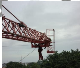
Gambar 17. Melepas sling hoist dari depan kabin sampai ujung jib Sumber : PT. Tatamulia Nusantara Indah, 2011.
