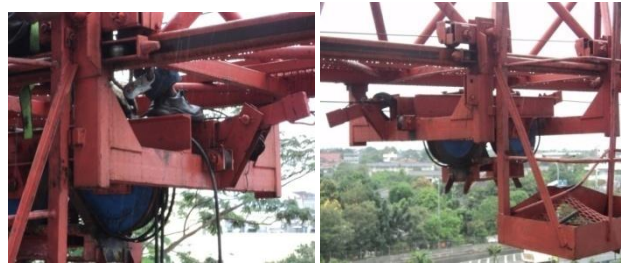
Gambar 18. Melepas sling trolley dari depan kabin sampai ujung jib
