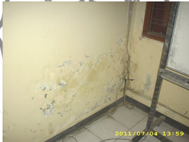
Gambar 4.9 Contoh cat dinding ruang kuliah yang mengelupas. (Sumber: Dokumentasi penelitian thn. 2011)
