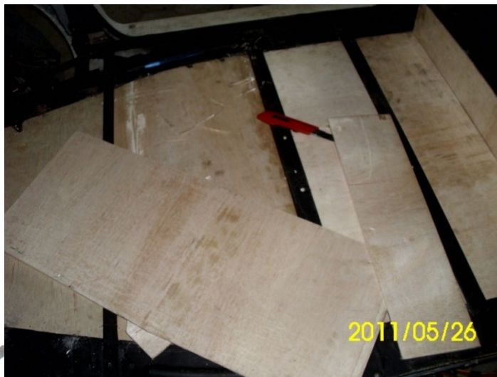
Gambar 4.3. Pembuatan landasan dari multiplek
