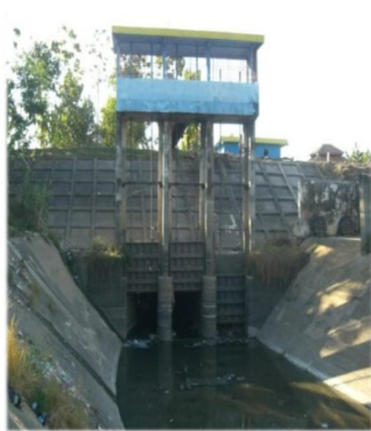
Gambar 3.3 Pintu Air Pucang Sawit di Hilir Kali Boro
