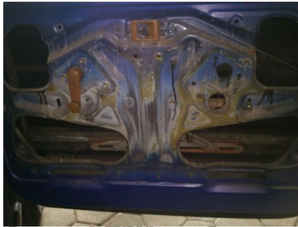
Gambar 4.27 Pintu mobil sebelum di lubang (kanan)
