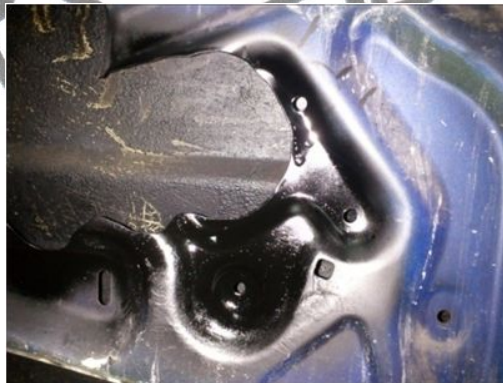
Gambar 4.36 Lubang yang telah mengalami proses pengecatan
