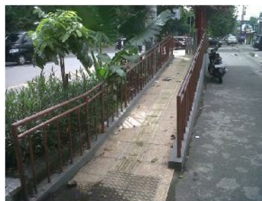
Gambar 5. Fasilitas Pembantu "Ramp"
