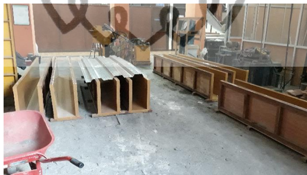
Gambar 4.1 Bekisting Balok yang Telah Dilapisi Lakban.
