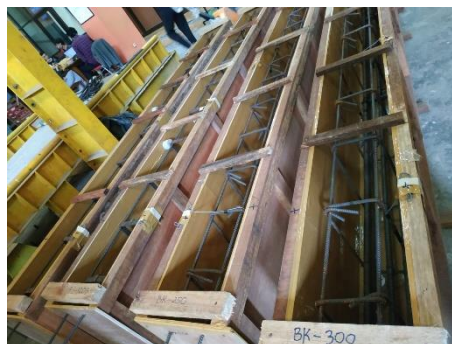
commit to user Gambar 4.3 Bekisting Berisikan Tulangan Balok yang Siap Dicor.
