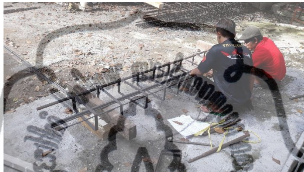
Gambar 4.2 Proses Pekerjaan Perakitan Tulangan Balok.
