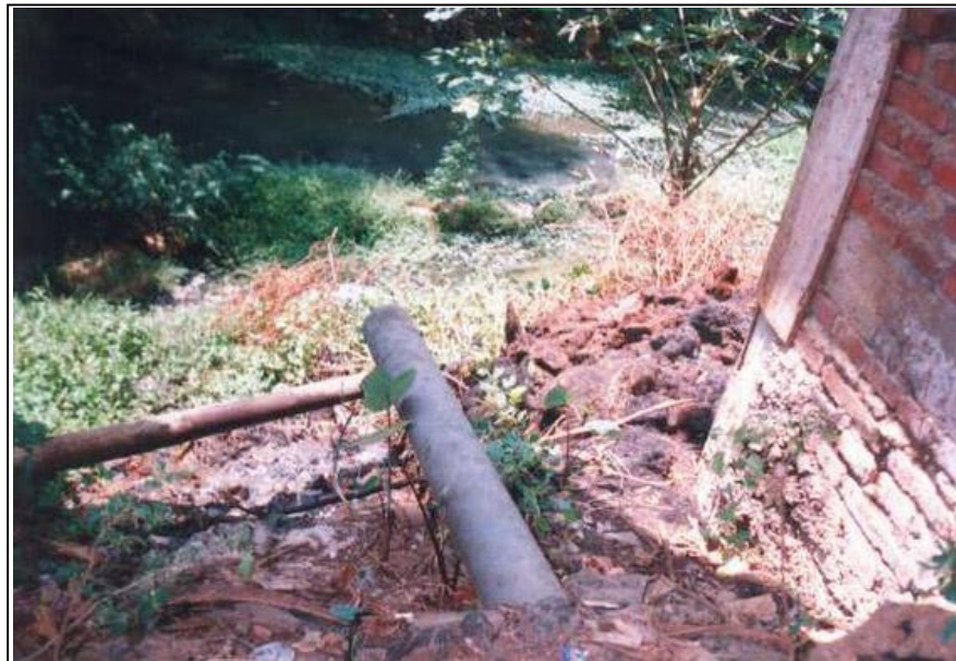
Gambar 43. Foto Saluran Pembuangan Air Limbah/ Air Kotor yang Dialirkan ke Sungai (Mei 2005)
