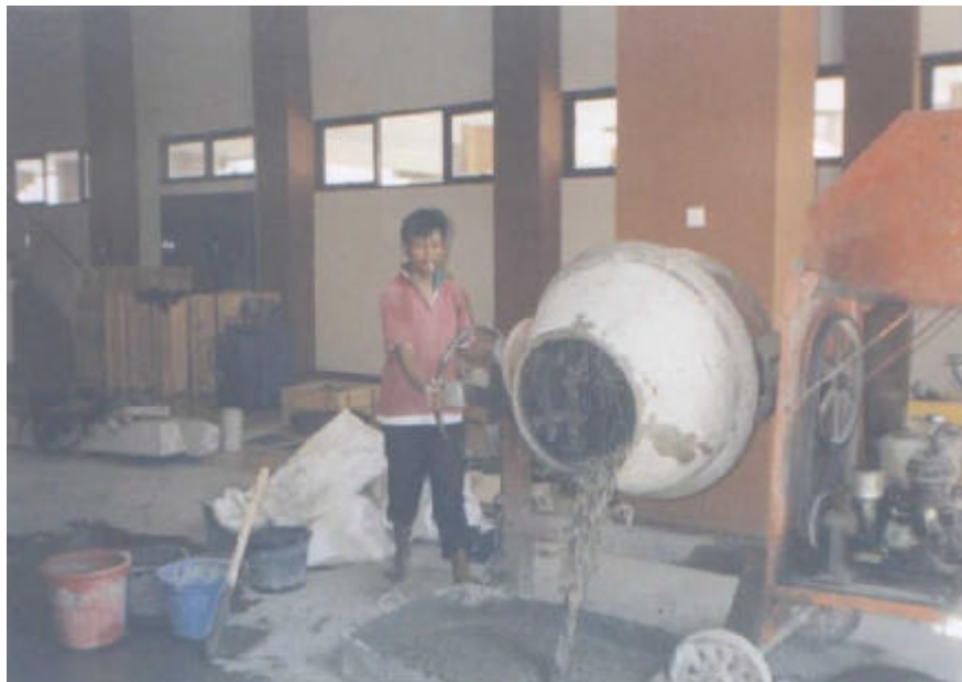
Gambar E.6 Pengadukan Menggunakan Molen ( Concrete Mixer )
