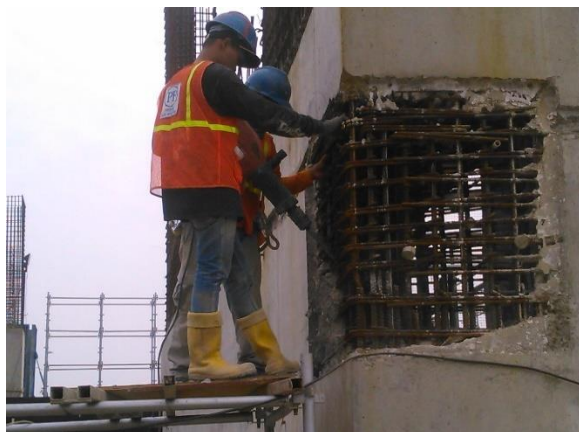
Gambar 5.19. Penghancuran Block Out
