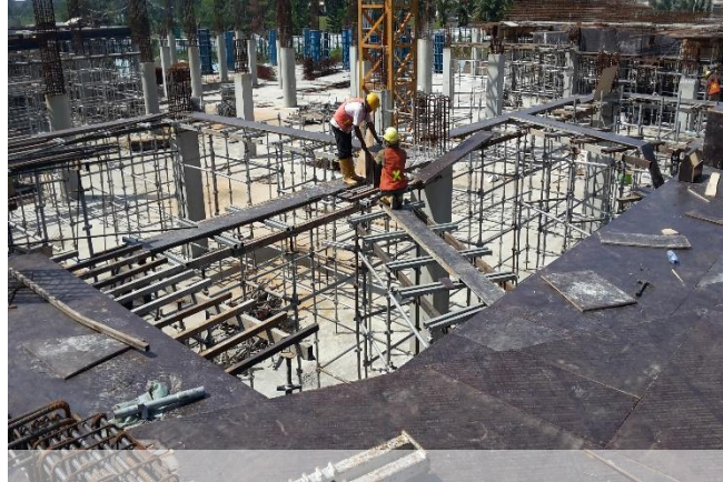
Gambar 5.8. Pemasangan Bekisting
