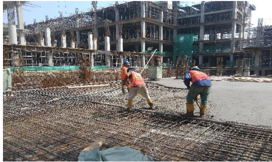
Gambar 5.11. Pengecoran Balok dan Pelat
