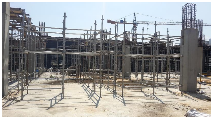
Gambar 5.7. Pemasangan Perancah
