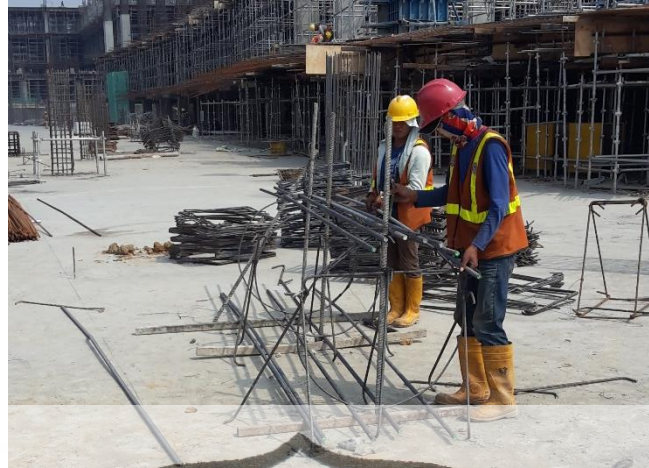
Gambar 5.2. Fabrikasi Tulangan Kolom
