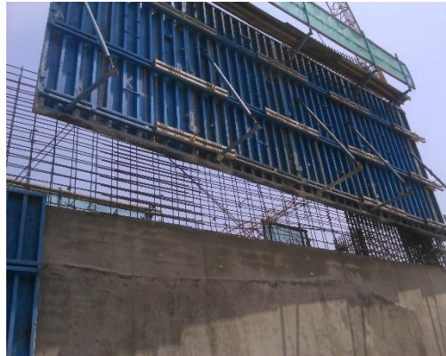
Gambar 5.18. Pengangkatan Bekisting
