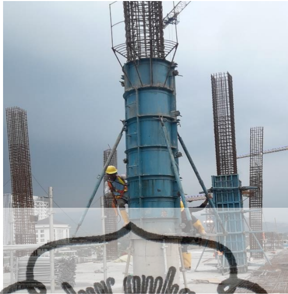
Gambar 5.6. Pembongkaran Bekisting Kolom
