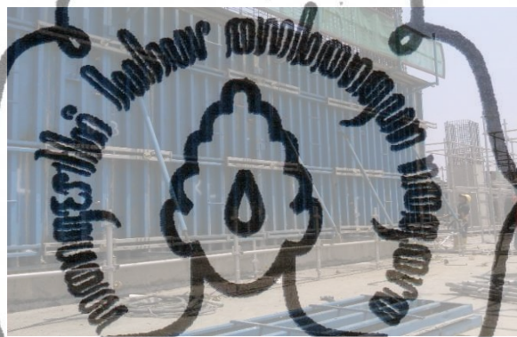
Gambar 5.16. Pemasangan Bekisting Vertikal
