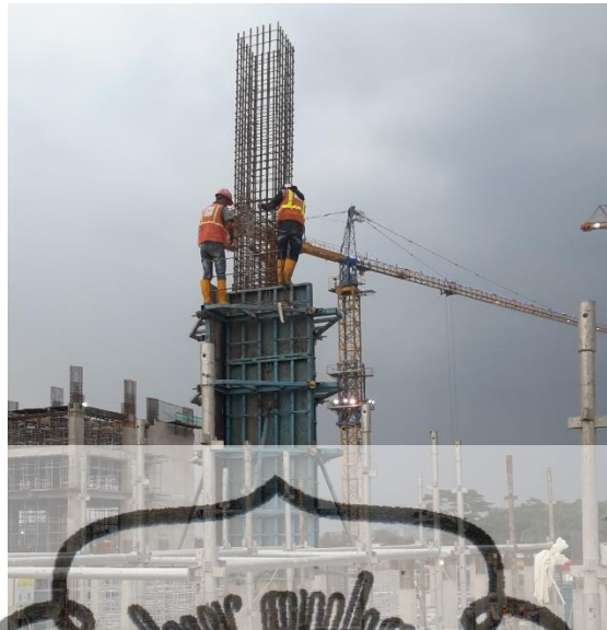
Gambar 5.4. Pemasangan Bekisting Kolom
