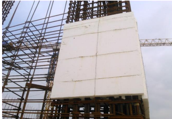
Gambar 5.15. Pemasangan Block Out
