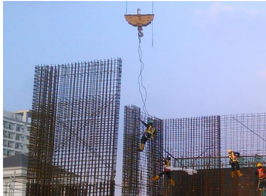
Gambar 5.14. Pemasangan Tulangan dengan Tower Crane
