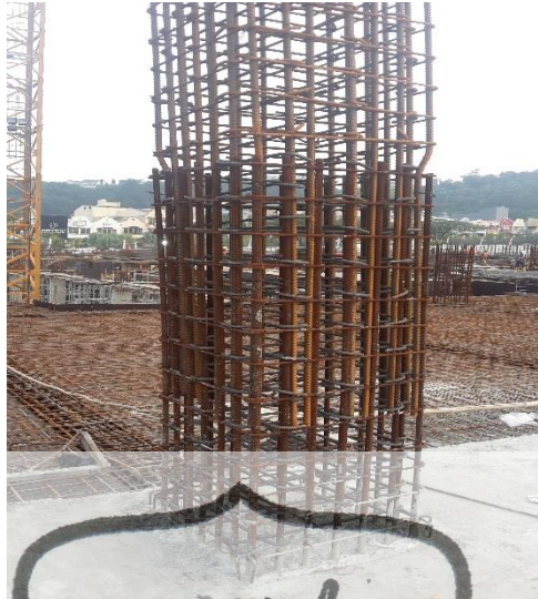
Gambar 5.3. Pemasangan Tulangan Kolom
