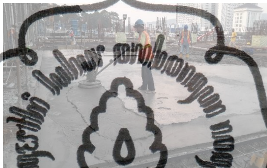
Gambar 5.12. Perataan Permukaan Pelat dengan Trowel
