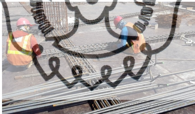
Gambar 5.9. Pemasangan Tulangan Balok
