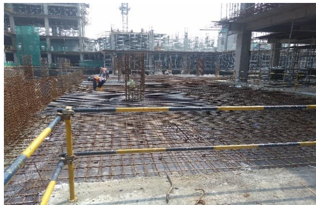
Gambar 5.10. Pemasangan Tulangan Pelat
