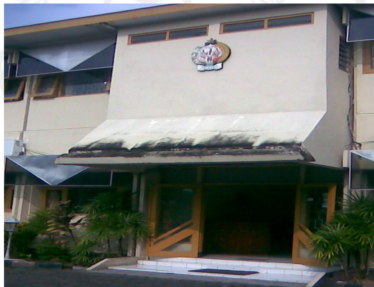
Gambar Gedung Unit Badran II. Jl. Tentara Rakyat Mataram No. 29 Yogyakarta.
