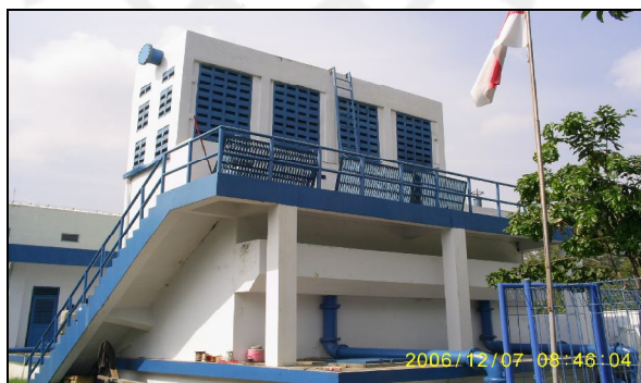
Instalasi Pengolahan Air Sumur Dalam Banjarsari
