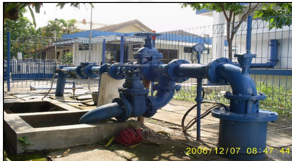
Konstruksi Sumur Dalam Banjarsari
