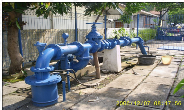
Konstruksi Sumur Dalam Banjarsari
