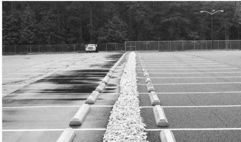
**Gambar 2. 4** Perbandingan penyerapan air pada aspal (kanan) dan pada paving berpori (kiri)
