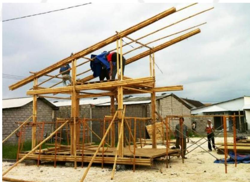
**Gambar 2. 17** Struktur rangka bamboo pada *Pemulung House*
